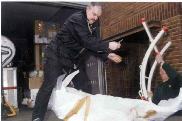
Die Einzelteile der Treppenliftsysteme werden nach exakten Terminvorgaben zum Kunden geliefert und dort fachgerecht montiert
